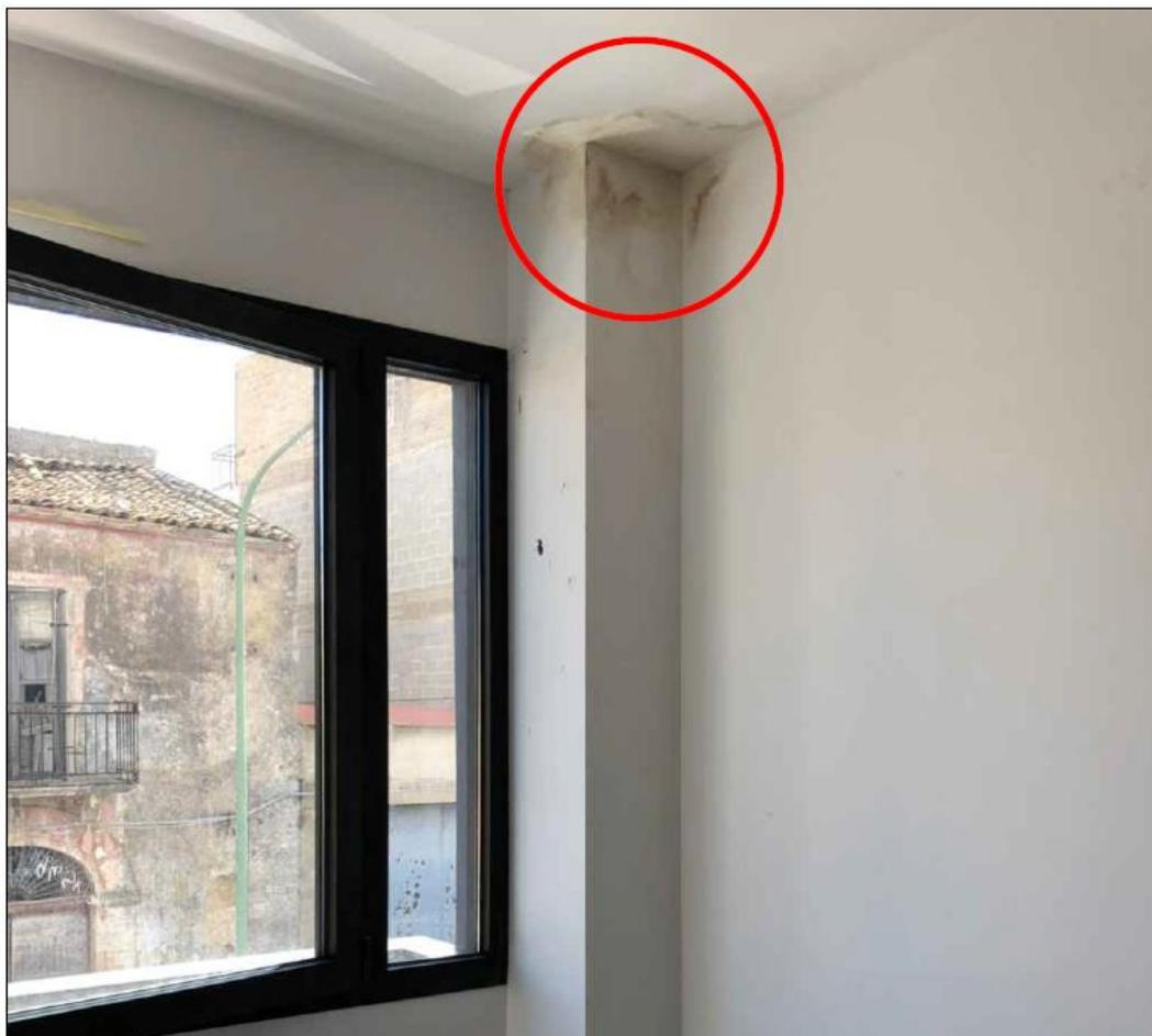
La macchia all'angolo viene denunciata come da infiltrazione della copertura : salvo verificare che l'elemento verticale non è un pilastro ma un cavedio e non si trova all'ultimo solaio bensì in un piano intermedio
