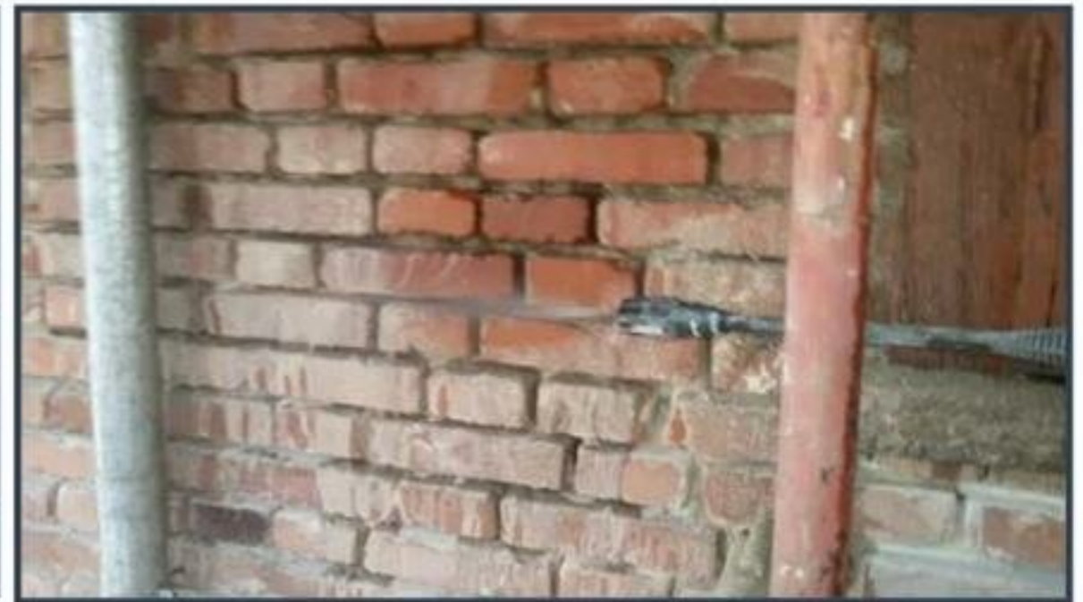
Idropulizia delle pareti in mattoni pieni
