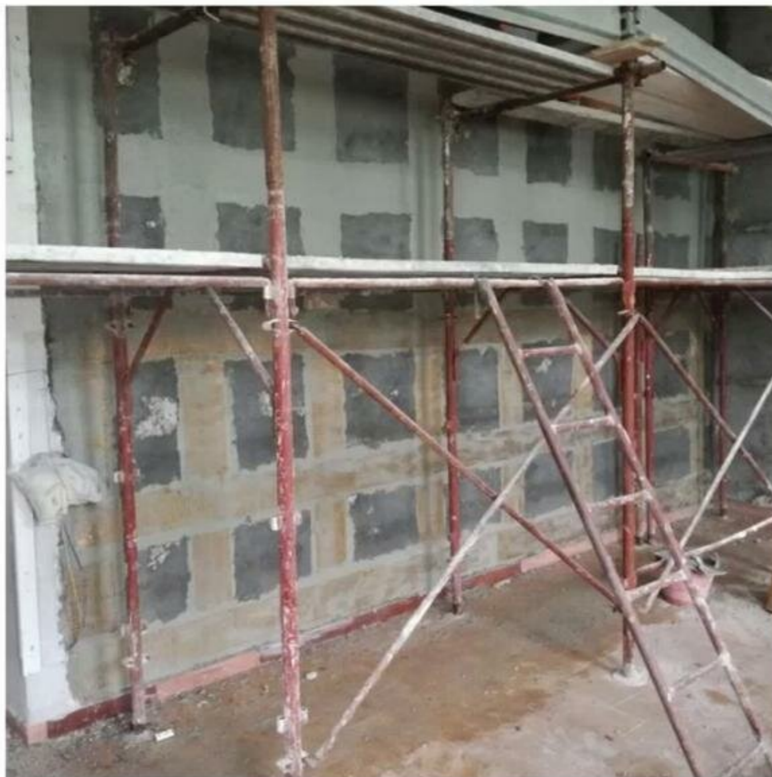
Schema tipo rinforzo con reti di PBO delle pareti murarie
