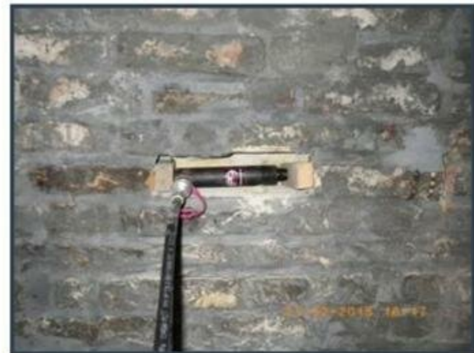
Prova su parte ristilata con HPRM
