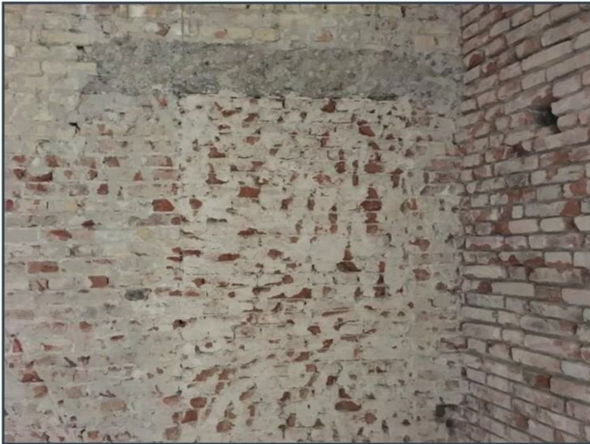
Esempio varco soppresso (senza cucirlo con il resto) rilevabile solo rimuovendo l'intonaco
