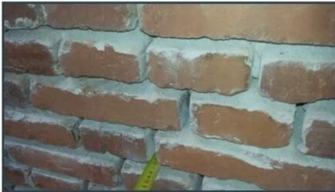
Profondità rimozione malta: min 3 cm - max 7 cm
