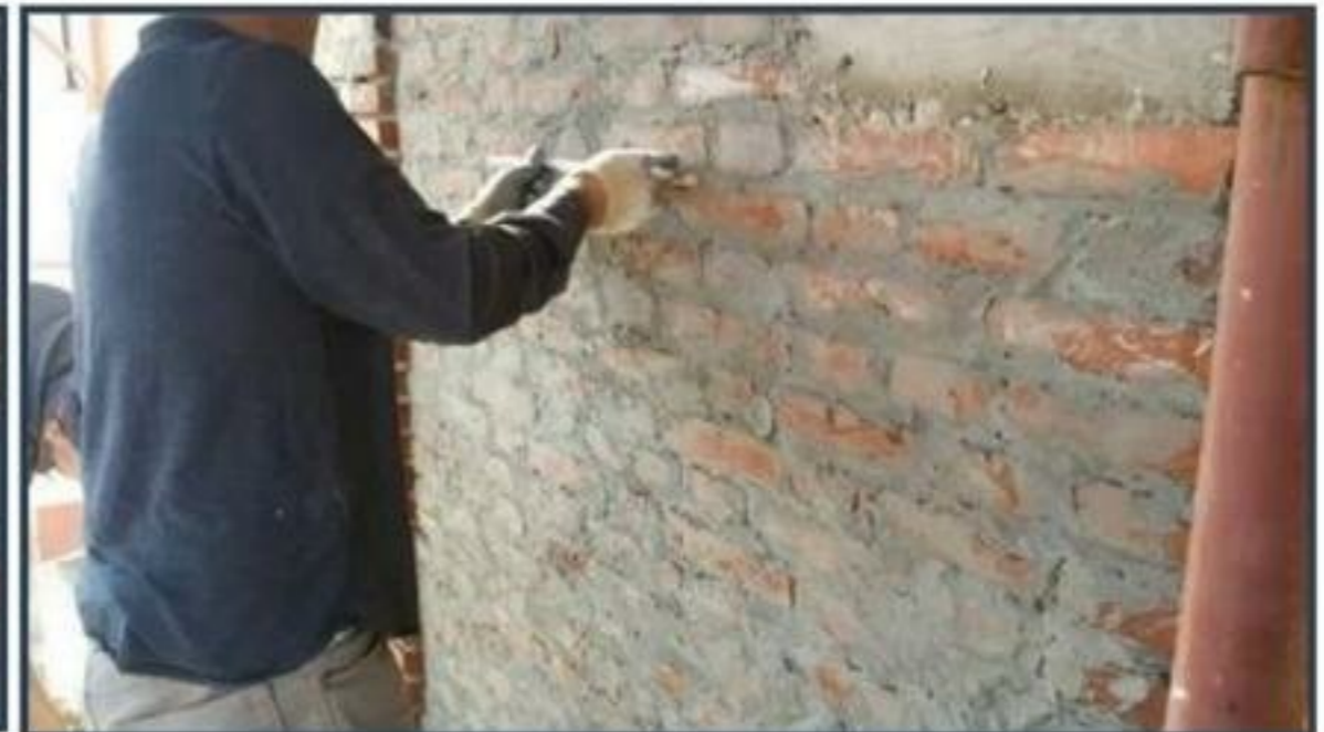
Livellamento a pressione della nuova malta
