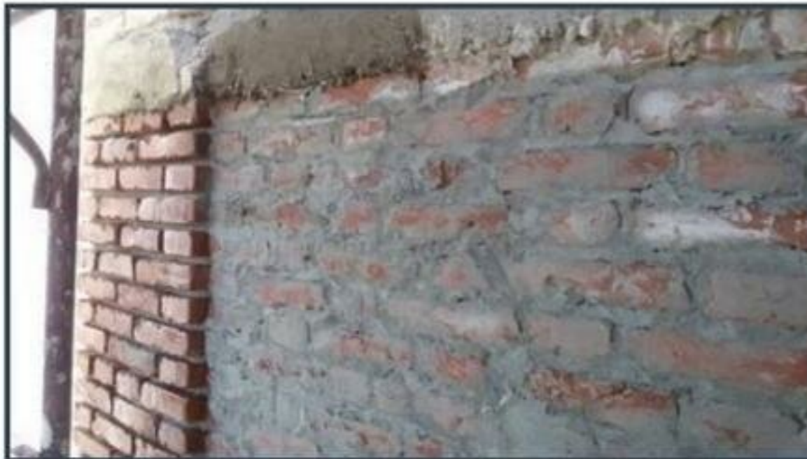
Rigenerazione dei giunti con malta aggiuntiva
